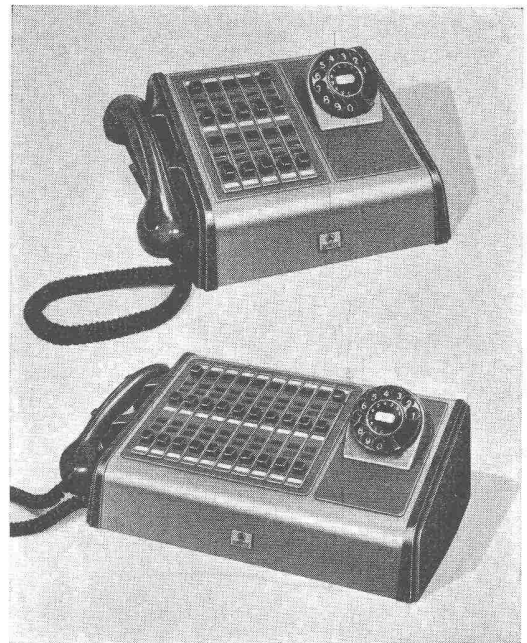
Bild 1. Die neue Albis-Telephonstation mit «variabler Länge»
