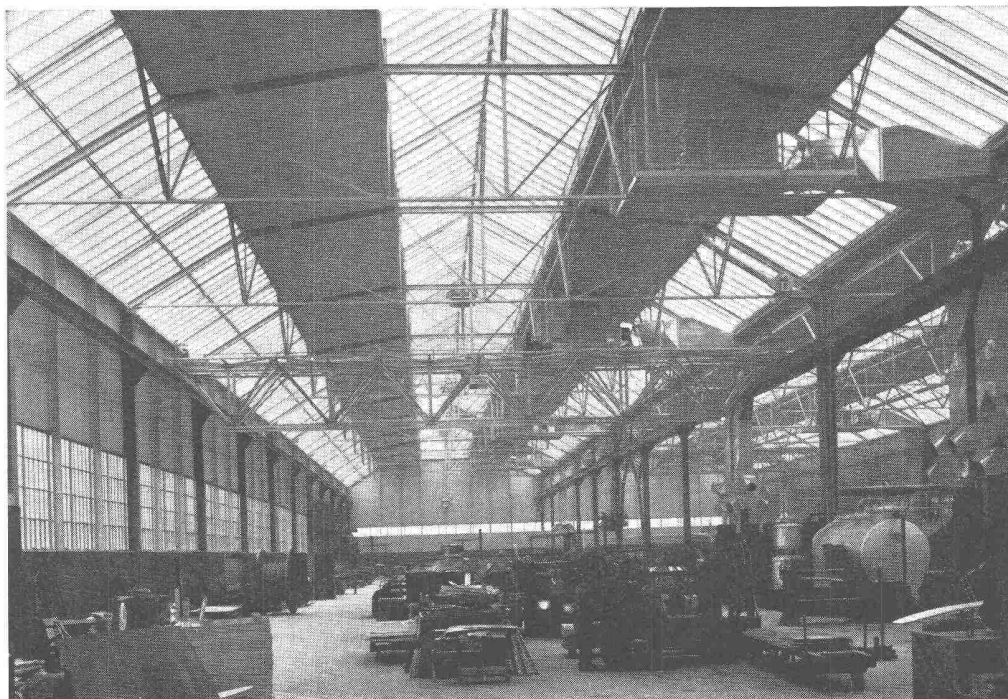
Produktionshalle, Krangerüst in Leichtmetall
