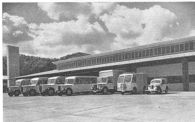
PTT-Garagen, Arch. E. Brantschen, St. Gallen
