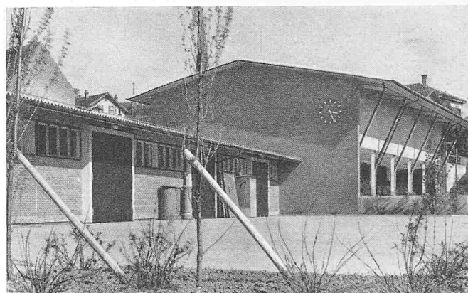
PTT-Bauten, Kabelschuppen, Arch. E. Brantschen, St. Gallen
