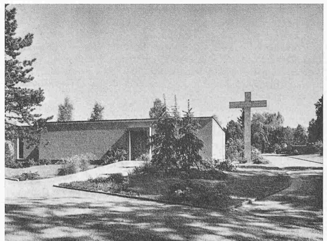
Leichenhalle Kesselhalden, Städt. Hochbauamt
