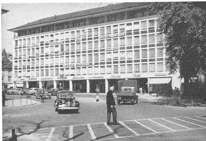
Uniongebäude, Arch. E. Häny &amp; Sohn †
