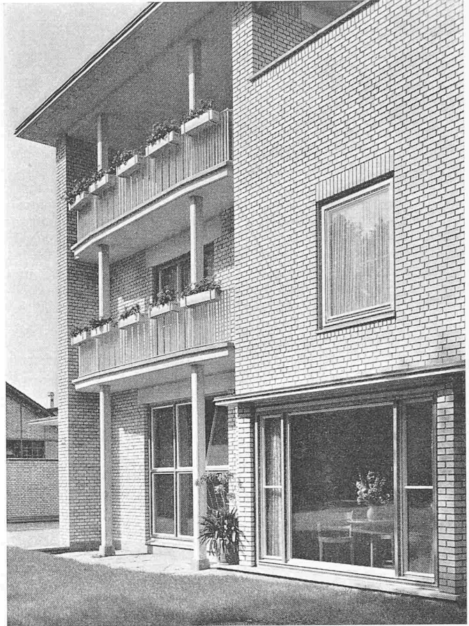
Bild 10. Südostecke des Wohlfahrtshauses
