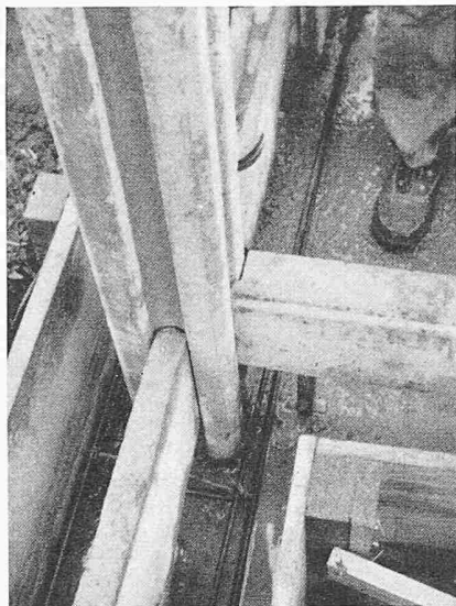
Bild 6. Eingiessen der Pfosten
