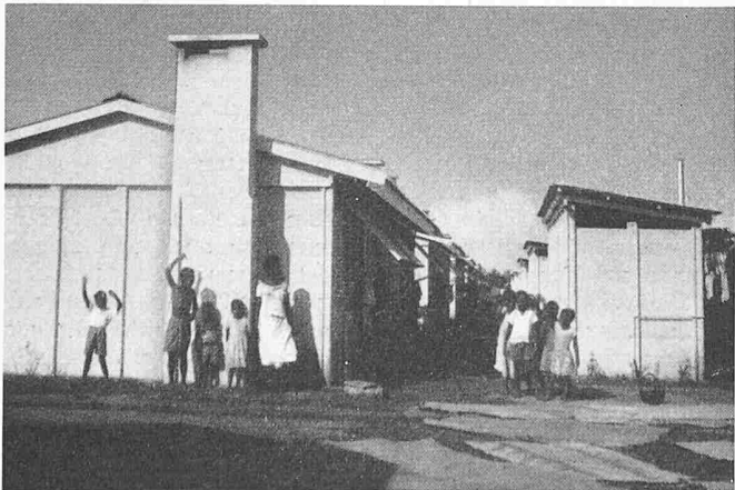
Bild 4. Stirnseite mit Nebenbau
