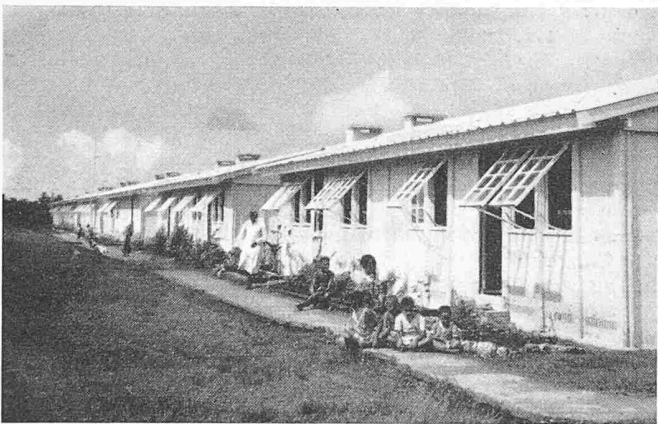
Bild 3. Vorderfront des neuen Haustyps
