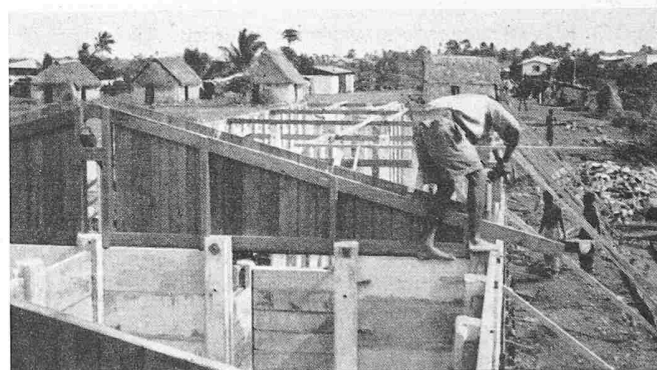
Bild 10. Befestigen der Holzbinder
