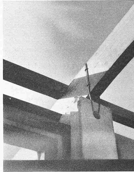
Bild 8. Befestigen der Zwischenbalken an den Pfosten
