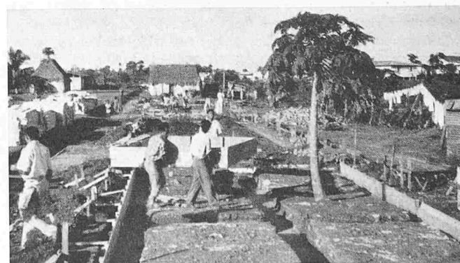
Bild 11. Vorbereitungen zum Aufstampfen der Beton-Grundplatte
