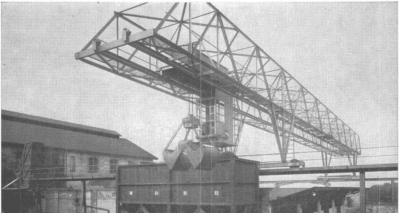
Verladebrücke in Schweisskonstruktion 2,5 t Tragkraft, 46 m Länge
