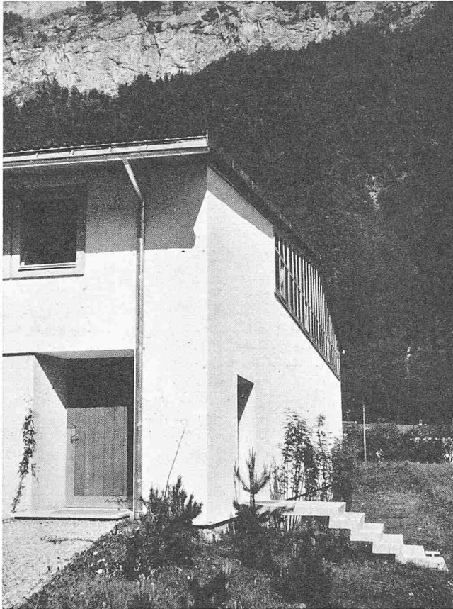
Bild 1. Eckpartie auf der Nord/Ostseite
