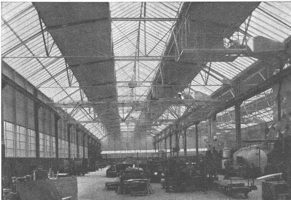
Produktionshalle, Krangerüst in Leichtmetall
