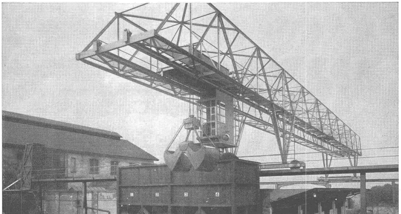
Verladebrücke in Schweisskonstruktion 2,5 t Tragkraft, 46 m Länge
