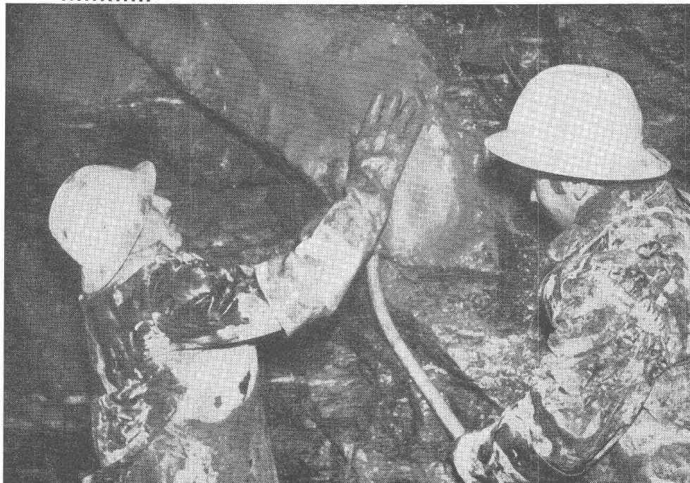
Kraftwerk Zervreila Abdichtung des Zulaufstollens mit Barra Rapid U
