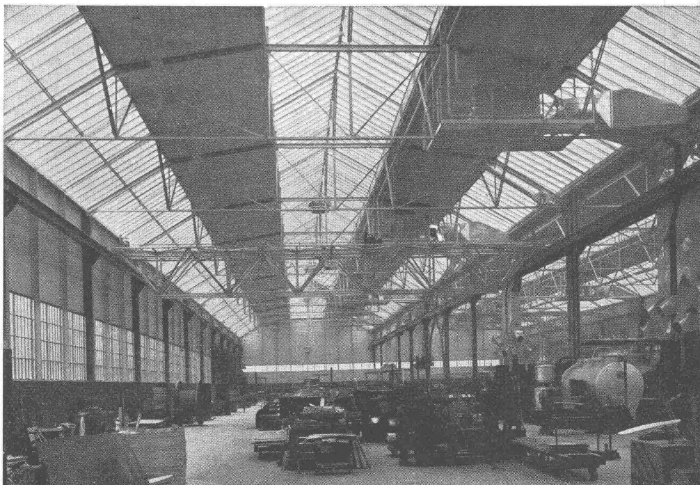
Produktionshalle, Krangerüst in Leichtmetall
