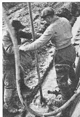
Bild 8. Ländernach-Kanal, Einspülen der Filterrohre
