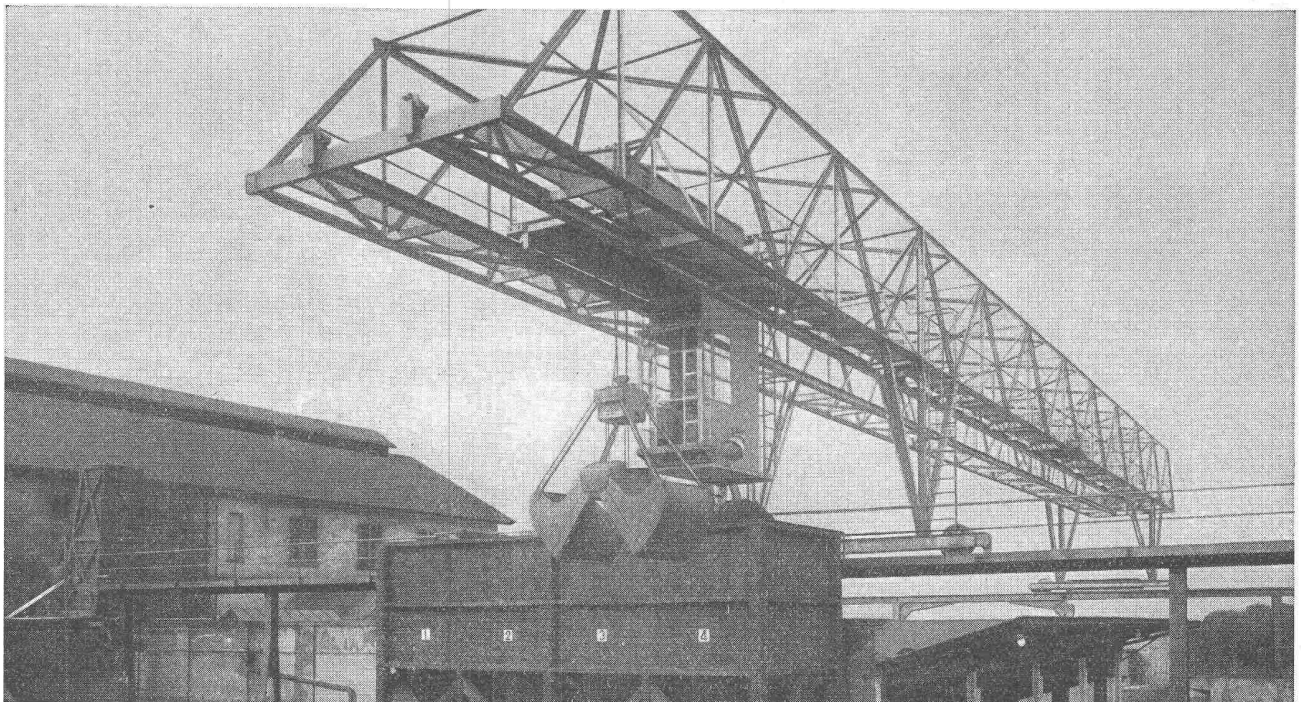
Verladebrücke in Schweisskonstruktion 2,5 t Tragkraft, 46 m Länge
