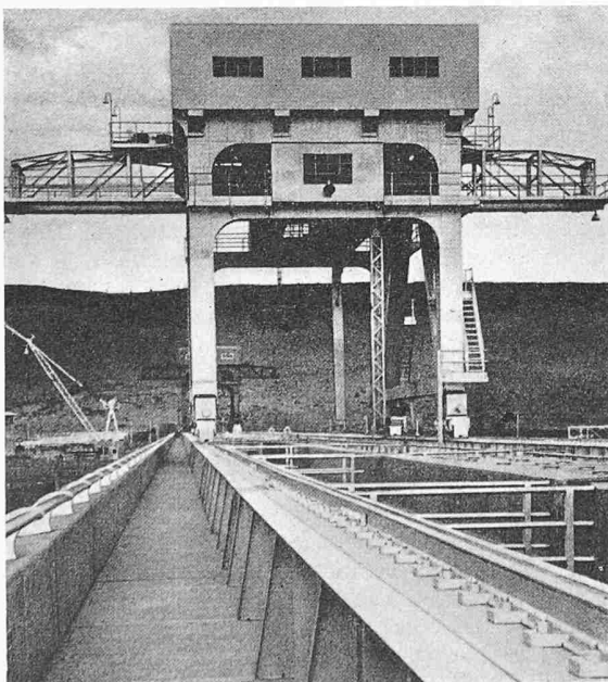
Bild 2. McNary-Stauwehr am Columbia River, USA, fahrbarer Portalkran zur Bedienung der Schützen
