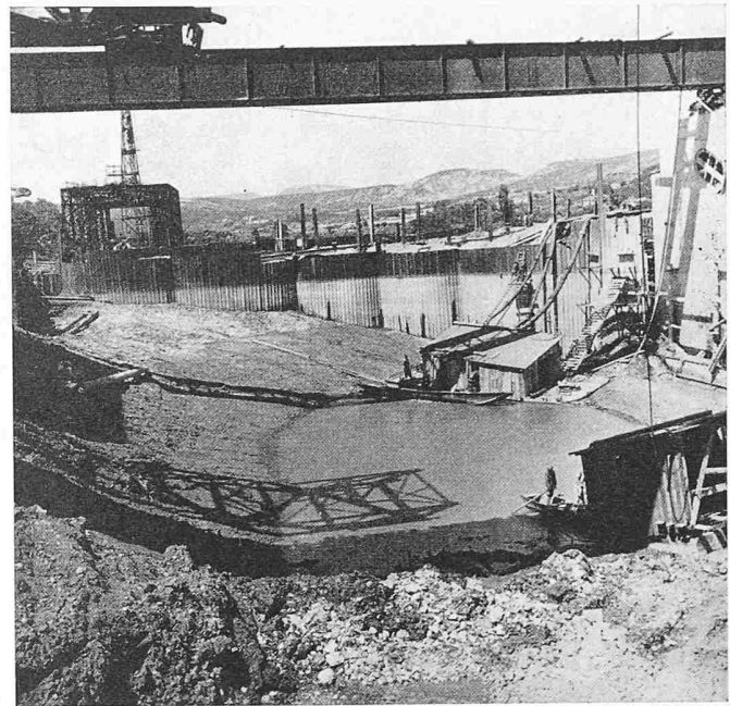
Bild 10. Abschluss der Schifffahrtsöffnung von 45 m durch Zellenfangdämme
