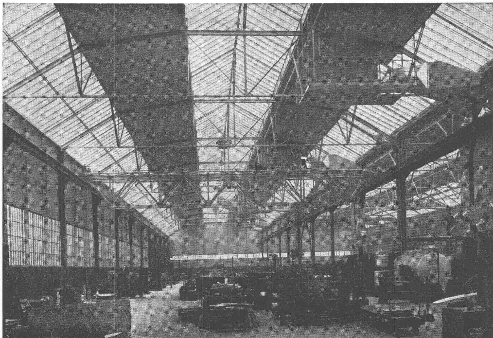
Produktionshalle, Krangerüst in Leichtmetall
