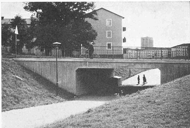
Bild 12. Fussgängerunterführung unter einer Fahrstrasse in Vällingby
