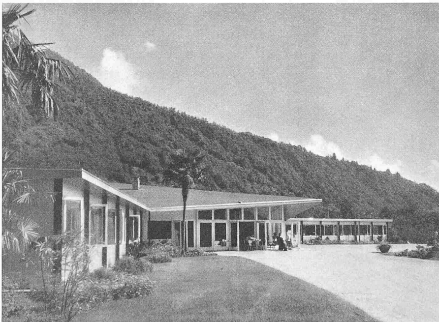
Bild 9. Teilansicht mit Halle
