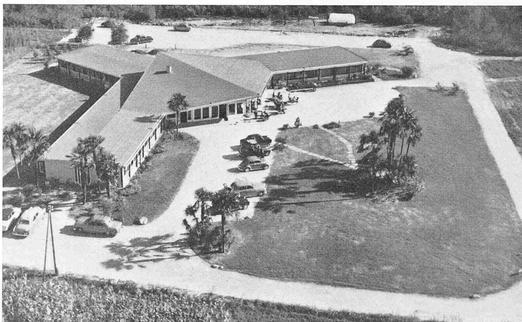
Bild 5. Fertiger Bau aus Südwesten
