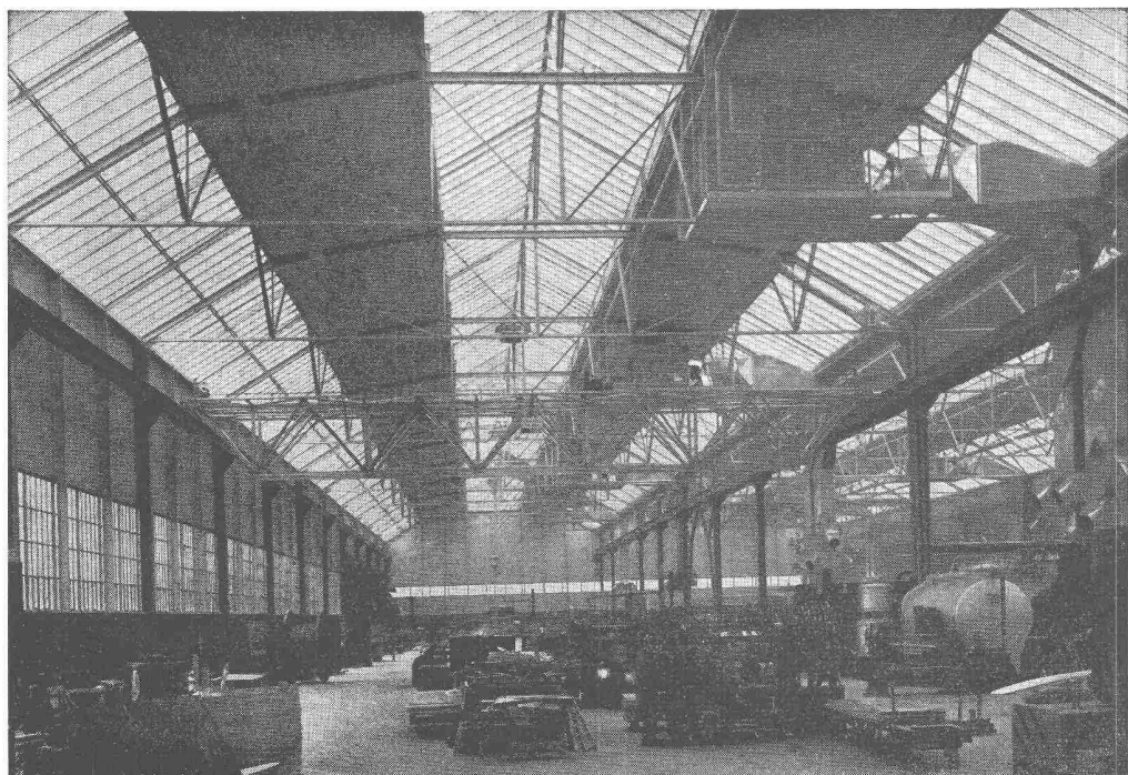
Produktionshalle, Krangerüst in Leichtmetall
