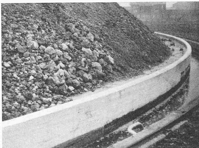
Bild 15. Grobes und feines Tropfkörpermaterial wahllos aufgeschüttet
