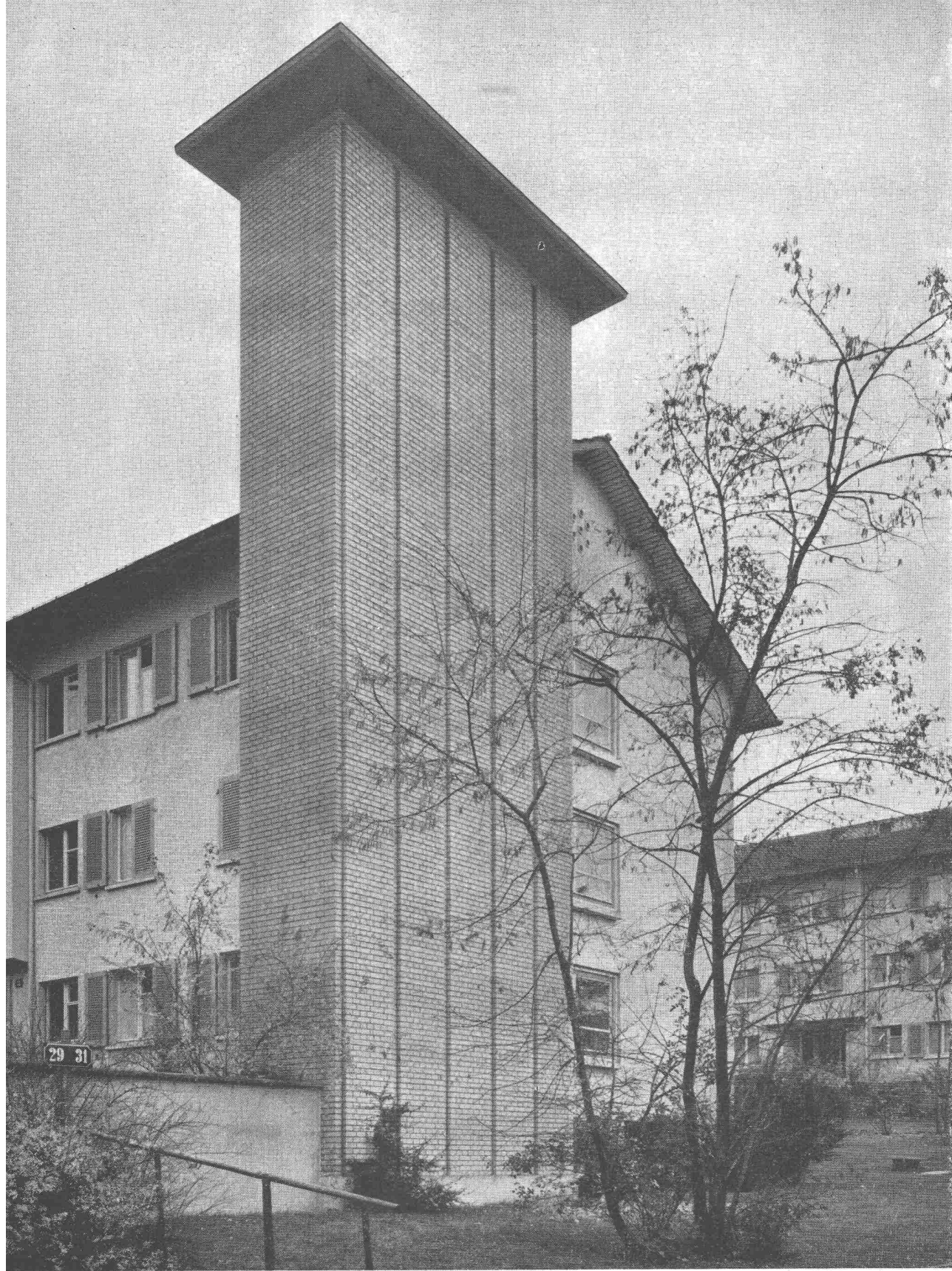
5-Züger Kamin einer Heiz- und Warmwasserzentrale
