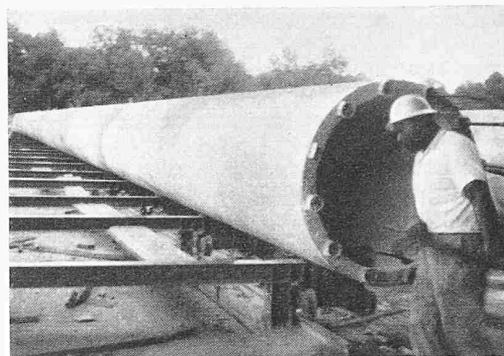
Bild 13. Vorgespannter, 25 m langer Pfahl
