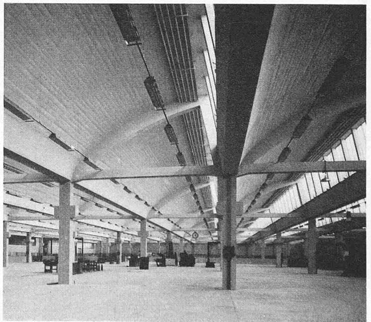
Bild 3. Hochtemperatur-Strahlungsheizung in einer Maschinenfabrik. Die Bandstrahler sind zwischen den Sheds angeordnet
