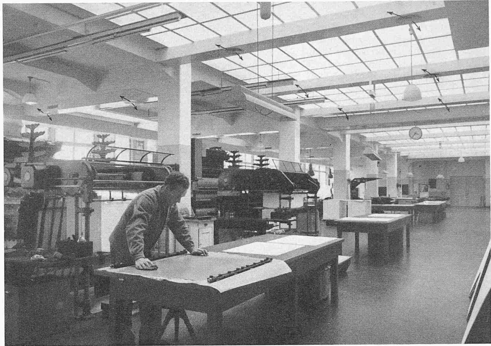
Bild 8. Teilansicht des Karten-druckraumes mit Zuluftkanälen an der Glasdecke und flachstreuenden Anemostaten zur Zuluftverteilung
