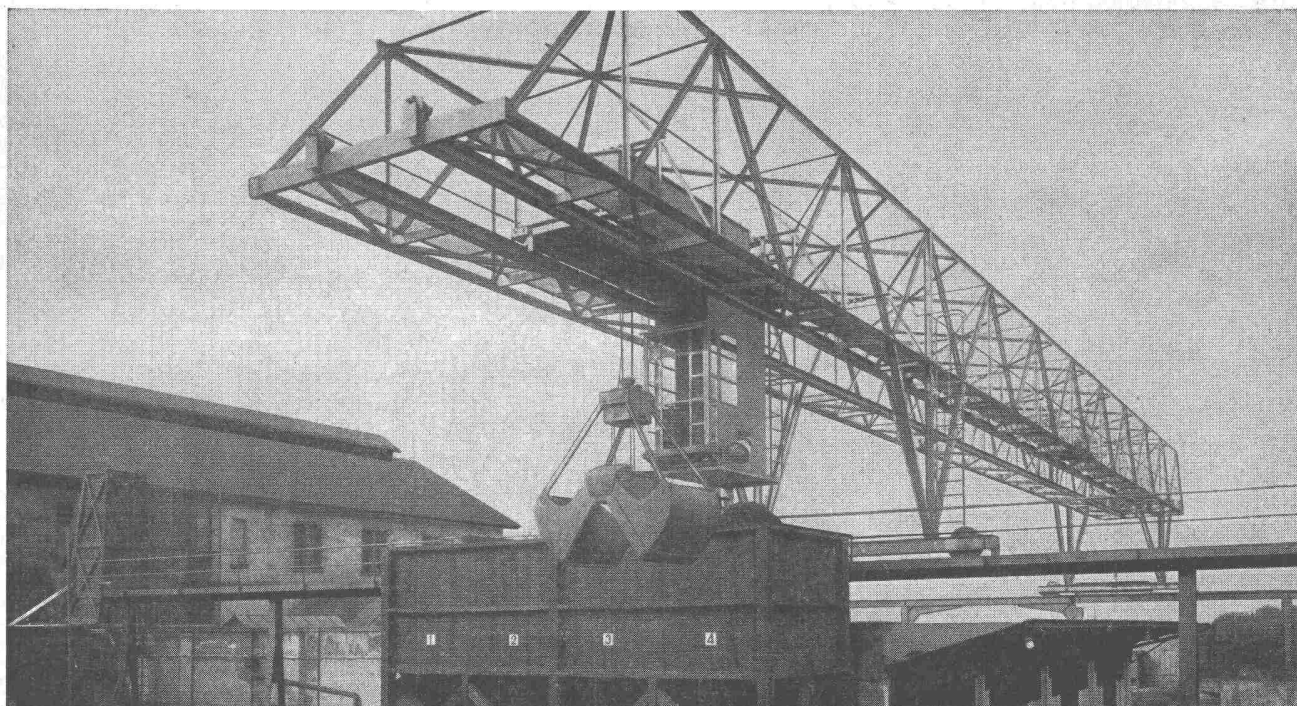
Verladebrücke in Schweisskonstruktion 2,5 t Tragkraft, 46 m Länge
