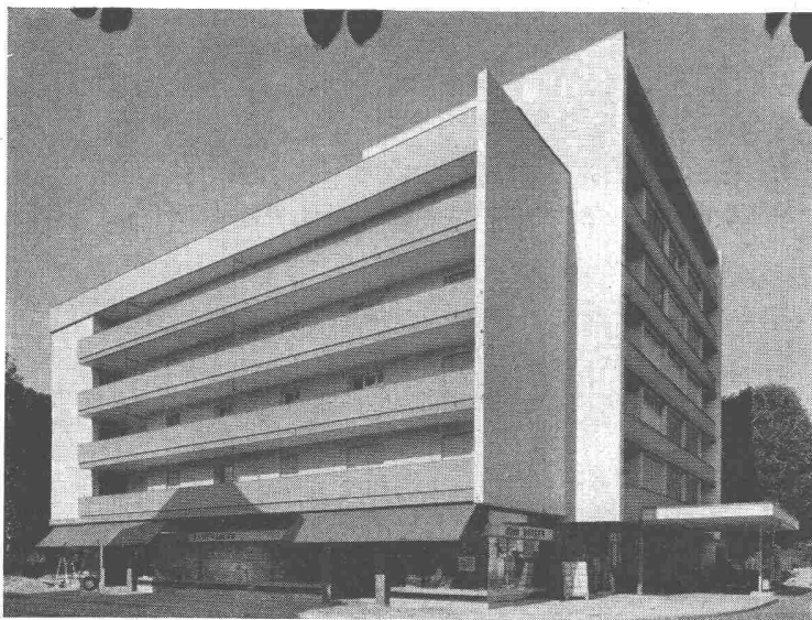
Farbenkonditionierung beim Fassadenanstrich
