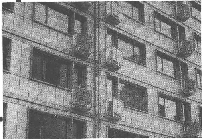
Ausfachung eines Beton-Skelettbaues
