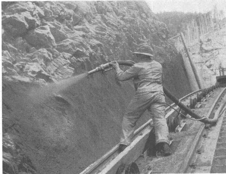
Felskonsolidierung bei der Druckleitung des Kraftwerkes Mauvoisin
