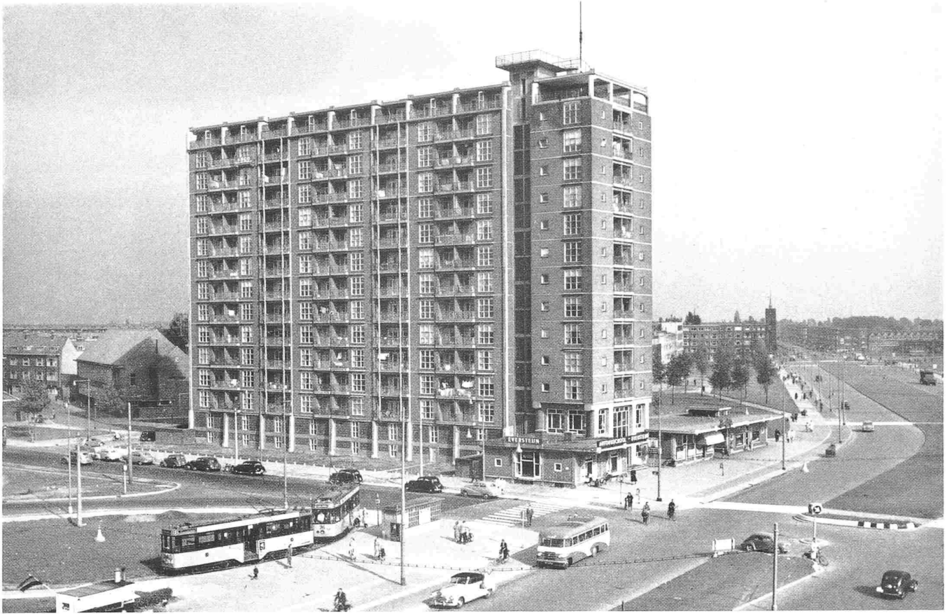
Hochhaus in Rotterdam. Ein ehrlicher zweckmässiger Bau, der ohne besonderen architektonischen Aufwand, nur durch die grossen Abmessungen und die mannigfaltige Wiederholung von an sich sehr einfachen Elementen, monumental wirkt. Dem menschlichen Masstab wird trotzdem keine Gewalt angetan. Arch. ir W. van Tijen & H. A. Maaskant
