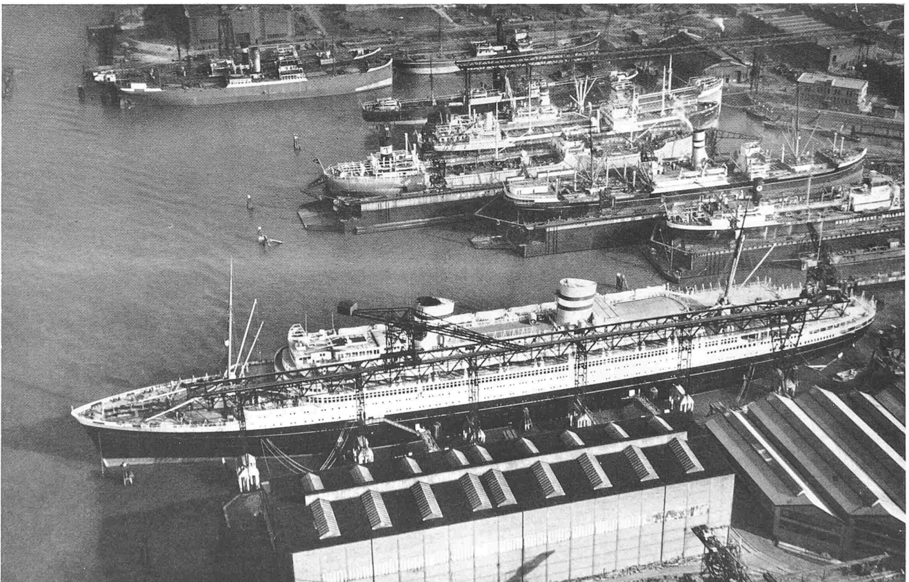
Rotterdamsche Droogdok Maatschappij N.V. Links: Zusammenbau (aus vorfabrizierten Teilen) des Cargo-Motorschiffes «Karimun» für die N. V. Stoomvaart Maatschappij «Nederland». Unten: Teilansicht der Werkbucht der «Rotterdamsche Droogdok Mij» in Rotterdam. Hinten verschiedene Schiffe in Schwimmdocks, davor das Doppelschrauben-Turbinenschiff «Nieuw Amsterdam», das grösste Schiff der Niederländischen Handelsmarine
