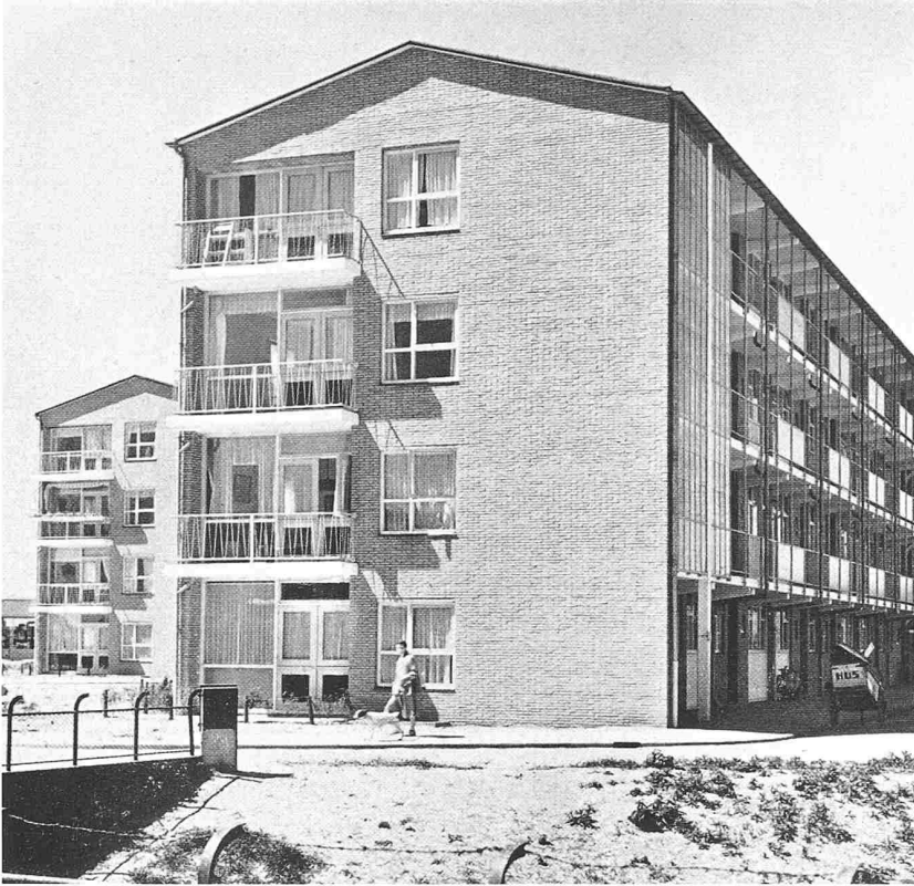
Galerie-Wohnungen in Voorburg bei Den Haag. Klare und saubere Architekturform, die mit einfachen Mitteln eine durchaus zeitgemässe Lösung erreicht. Arch. R. de Vries
