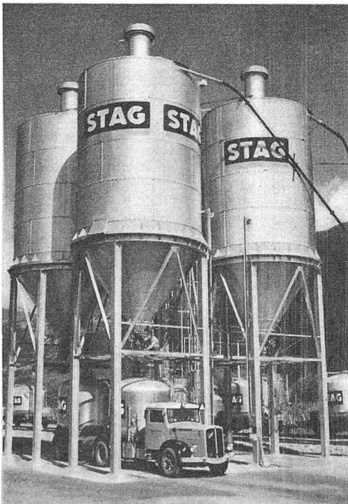
Bild 14. Anlage zu 4 Zementsilos für je 150 m 3 für den Umschlag von Schmalspur-Eisenbahnwagen in Strassen-Silo-Fahrzeuge
