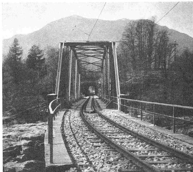
Bild 9. Durchsicht (im Hintergrund, in einiger Entfernung, kleiner Tunnel). Beginn der Kurve des Gleises noch auf der Brücke
