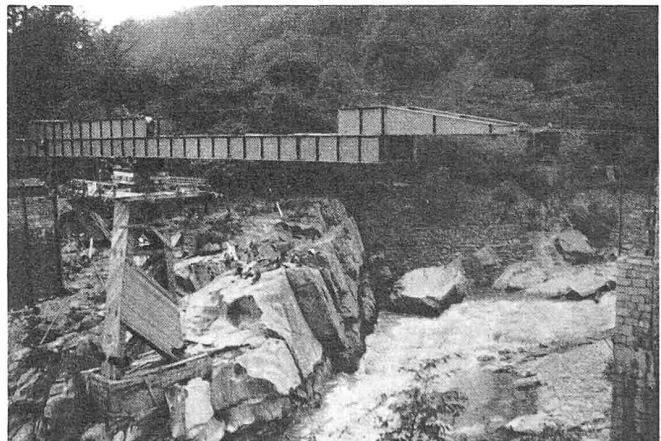
Bild 1. Montage der Notbrücke. Der Schnabel und die Aufdoppelung der Hauptträger sind lediglich während des Vorschiebens erforderlich. Der fertig verschaltete Pfeiler und der hier noch nicht erstellte Holzsporn auf der Oberwasserseite sind aus Bild 7 ersichtlich
