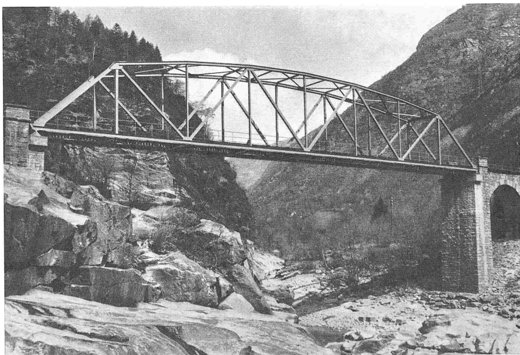
Bild 8. Gesamtansicht der neuen Brücke in endgültiger Höhenlage. — Bilder 7 bis 9. Phot. W. Tannaz, Locarno
