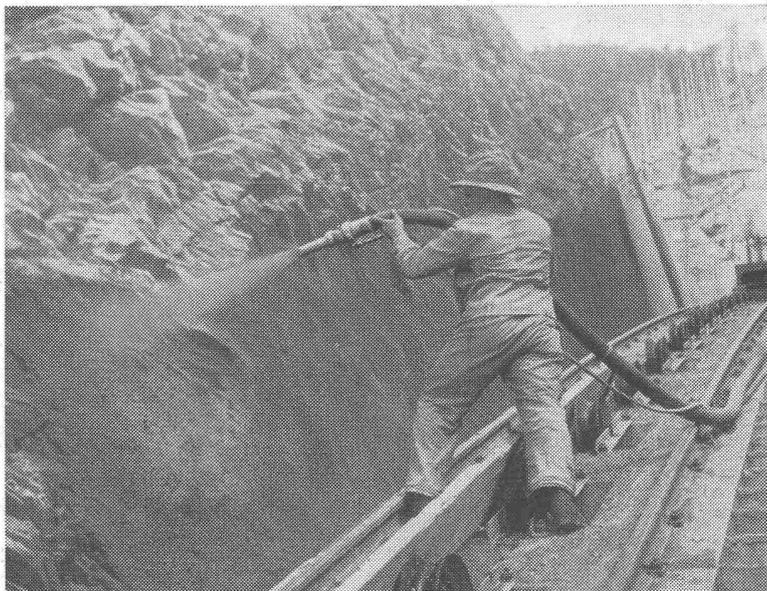
Felskonsolidierung bei der Druckleitung des Kraftwerkes Mauvoisin
