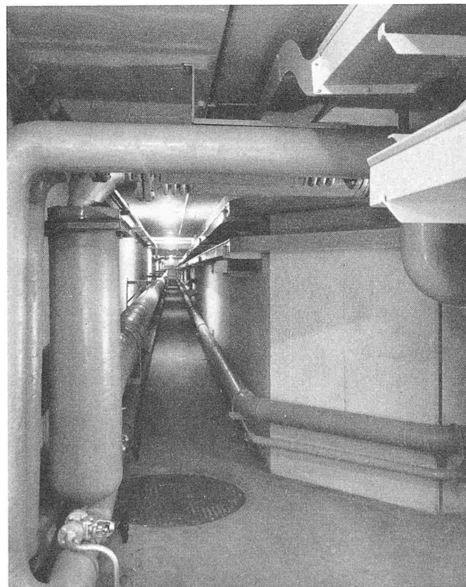
Bild 8. Begehbarer Leitungskanal
