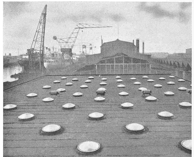
Dach mit runden Cupolux-Oberlichtern
