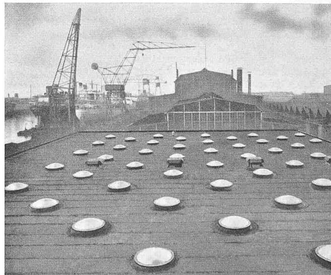
Dach mit runden Cupolux-Oberlichtern
