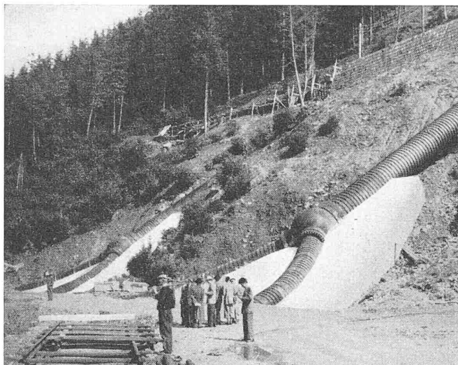
Bild 39. Kugelförmige Verteilstücke nach G. Ferrand, von 3,2 m Innendurchmesser
