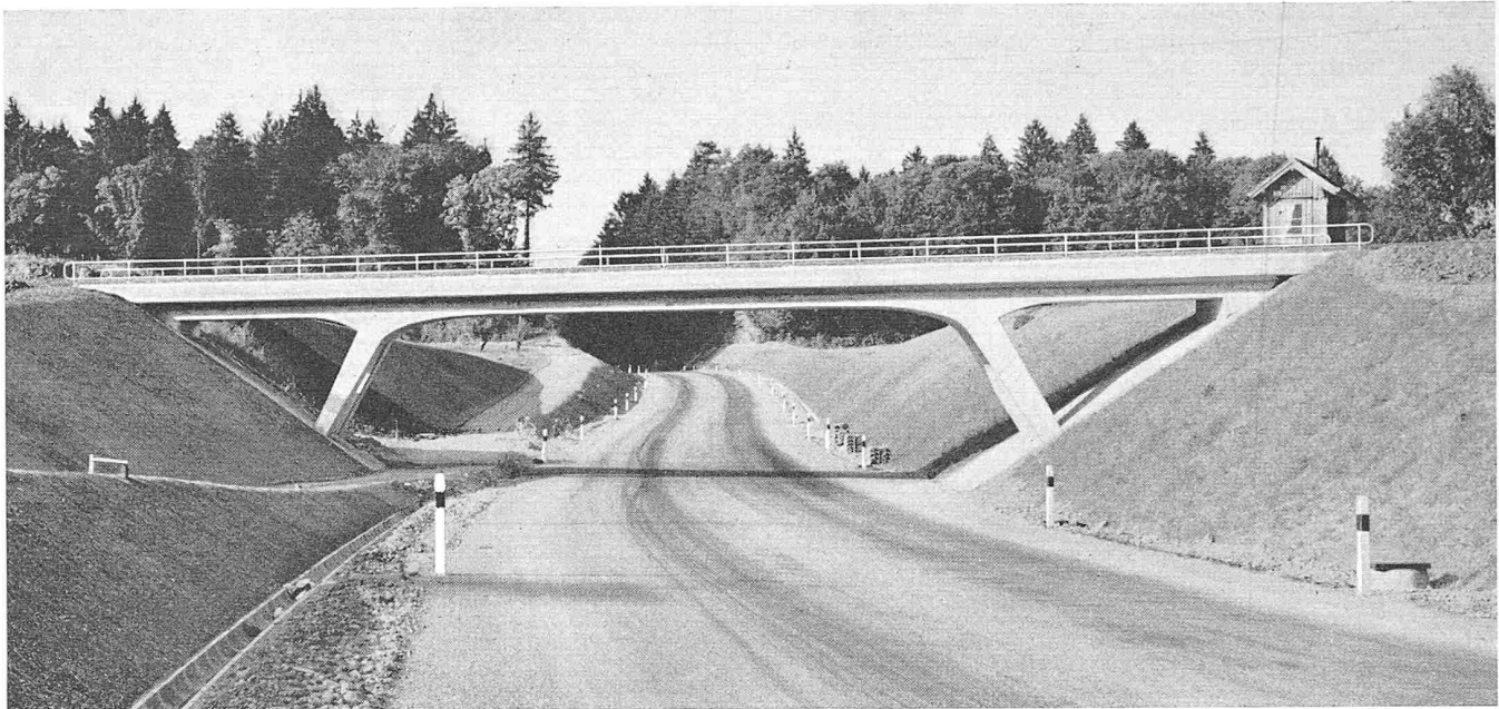
Bild 1. Die Stigli-Brücke der SBB bei Andelfingen, aus Süden
