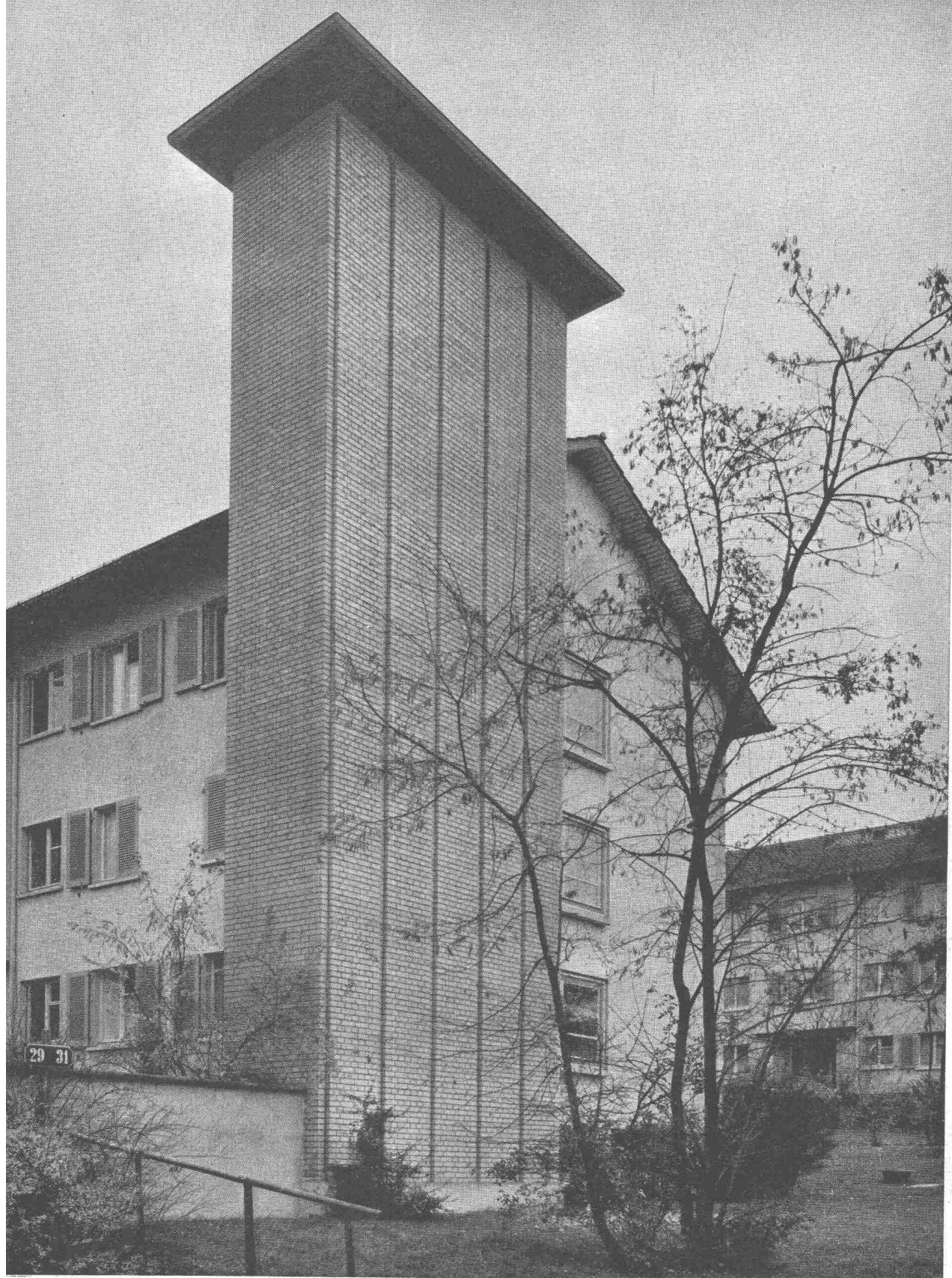
5-Züger Kamin einer Heiz- und Warmwasserzentrale
