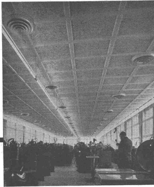
Klimaanlage, «System Häusler» in Uhrenfabrik
