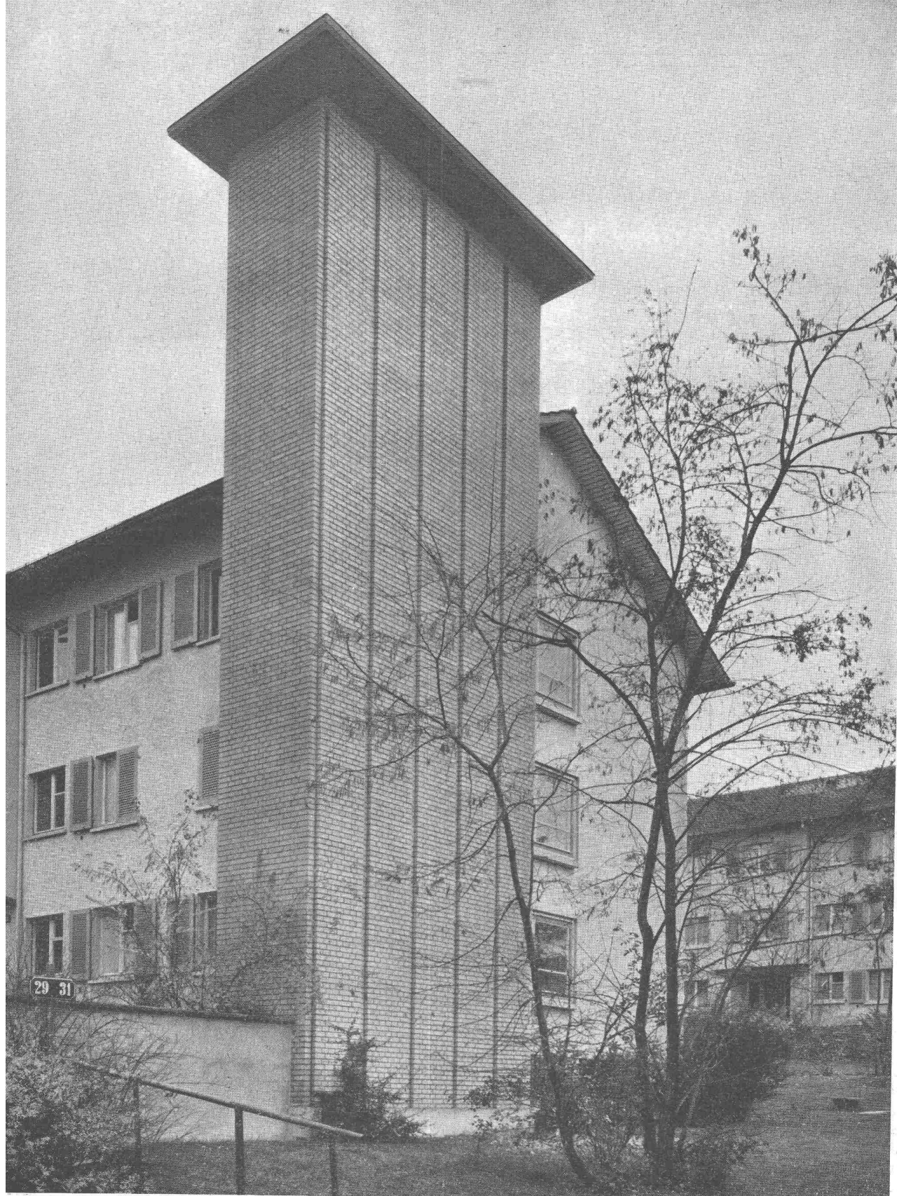
5-Züger Kamin einer Heiz- und Warmwasserzentrale
