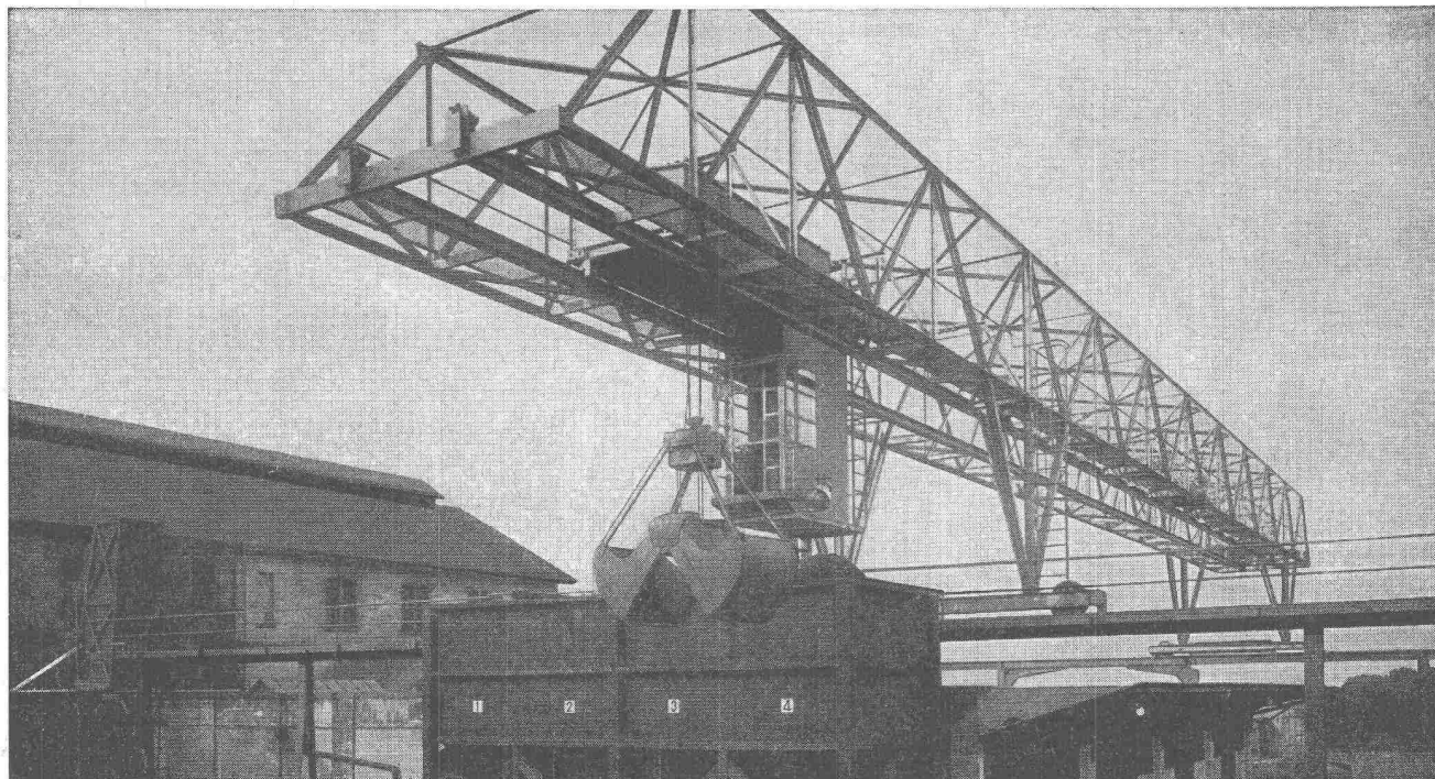
Verladebrücke in Schweisskonstruktion 2,5 t Tragkraft, 46 m Länge
