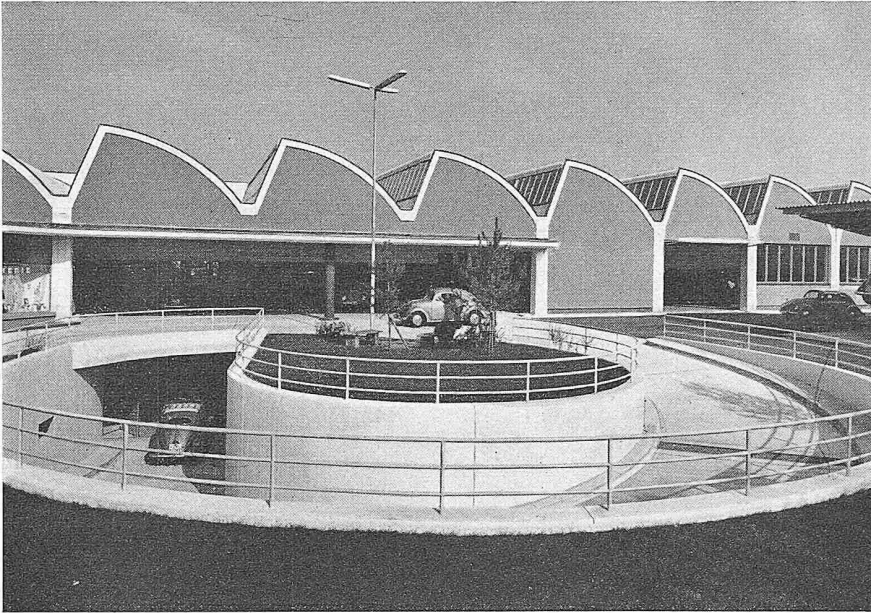
Bild 5. Einfahrt zur Wagenabnahme und Abfahrtsrampe zu Serviceabteilung
