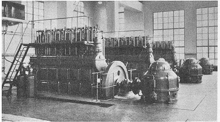
Bild 11. Abwasserwerk Clichy mit Sulzer-Dieselpumpengruppen
