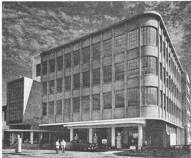
Garagebau in Cape Town, kombiniert mit Fabrikräumen in den oberen Geschossen; Eisenbetonskelett
