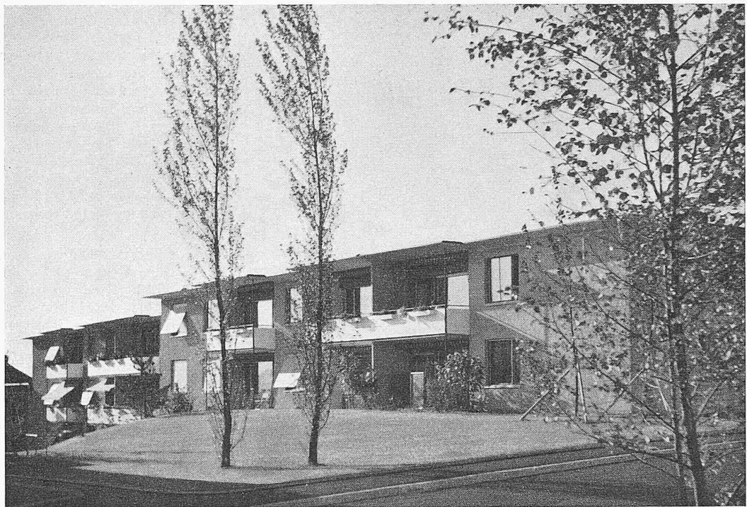
Block 2 aus Südosten
