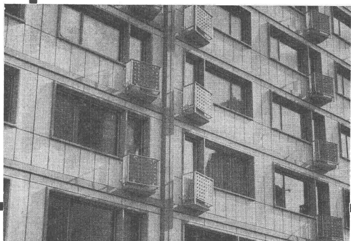
Ausfachung eines Beton-Skeletthaues
