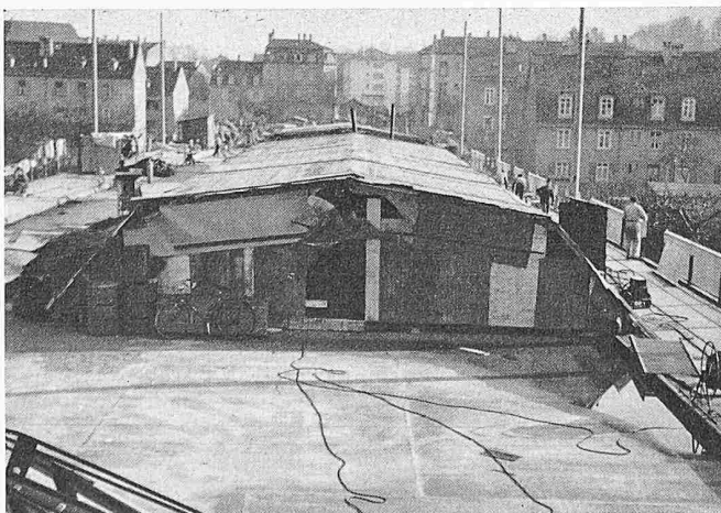
Bild 39. Fahrbares Schutzdach auf dem Fahrbahn-Deckblech
