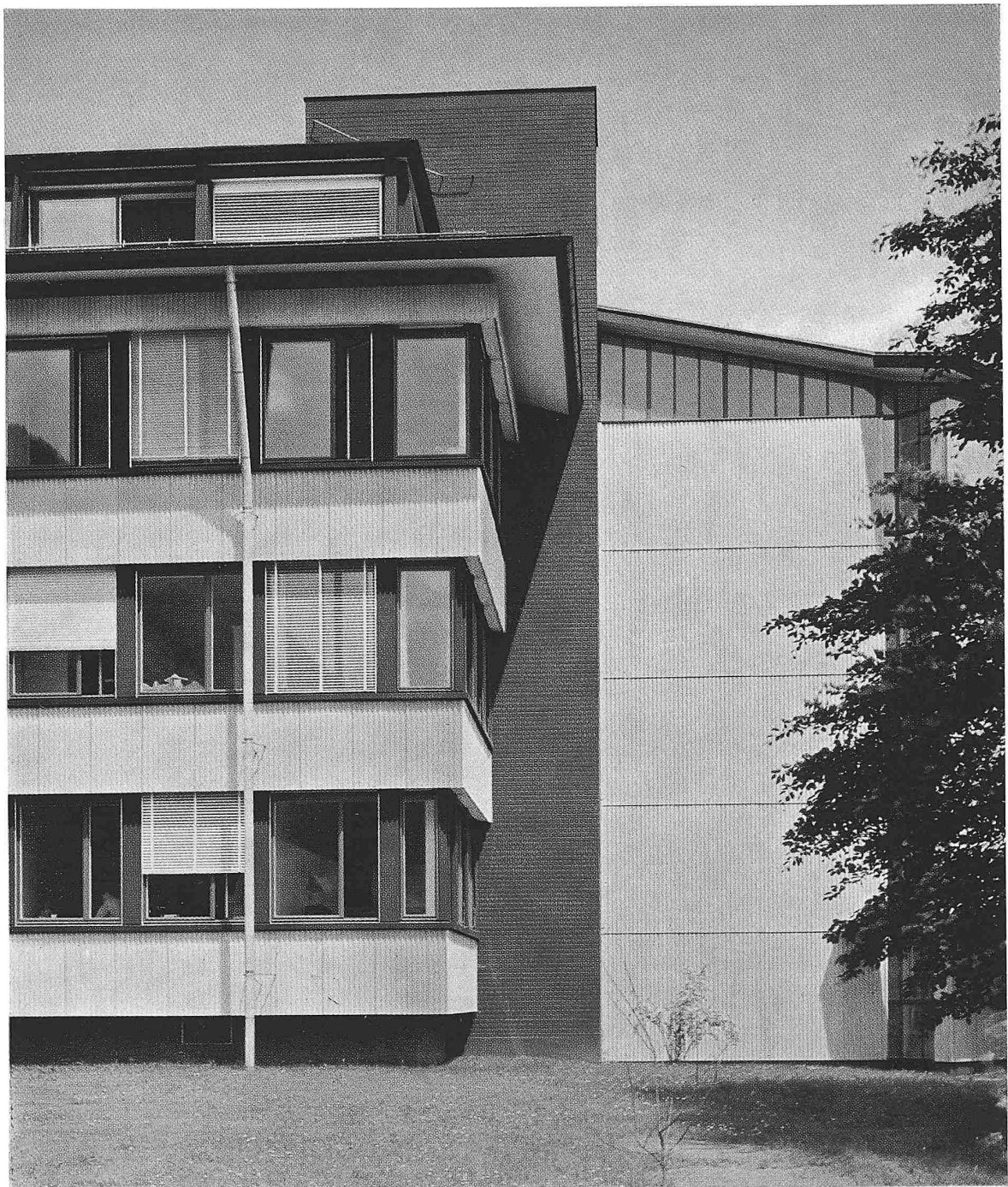
Detail der Südfassade: links Bürohaus, rechts Ausstellungstrakt
