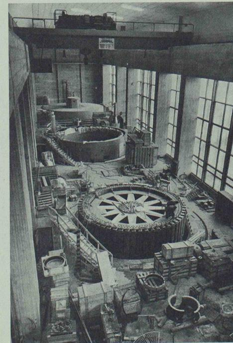
Bild 11. Maschinensaal bei der Montage des zweiten Aggregates
