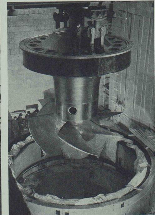
Bild 12. Einbau des Bell-Laufrades mit Turbinendeckel
