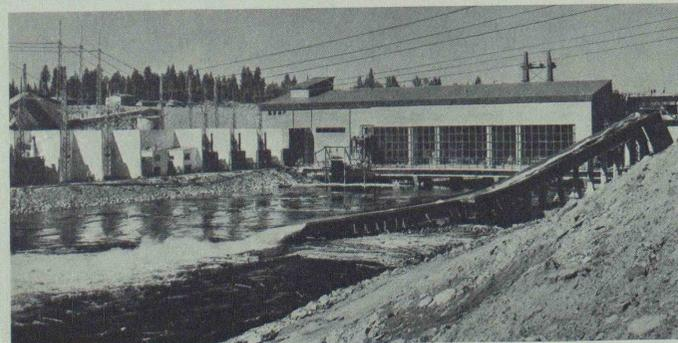
Bild 8. Kraftwerk von Unterwasserseite; rechts Flössrinne, links Schaltanlage
