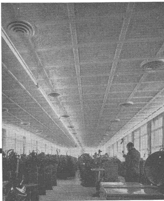
Klimaanlage «System Häusler» in Uhrenfabrik
